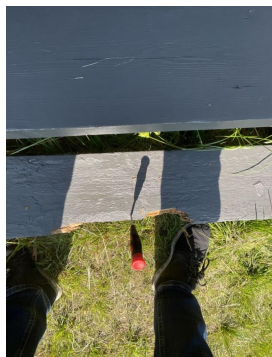
Første trinn på trapp er råteskadet.
