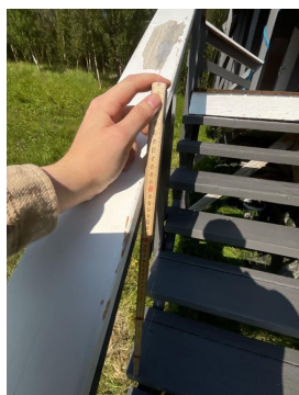
Rekkverks høyde er cirka 71 cm.
