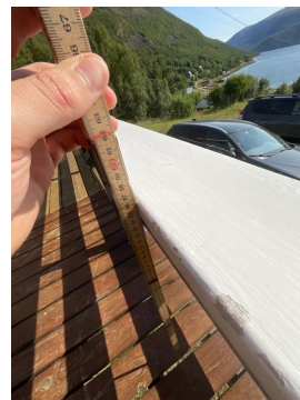
Rekkverks høyde utfor stue er 56 cm.
