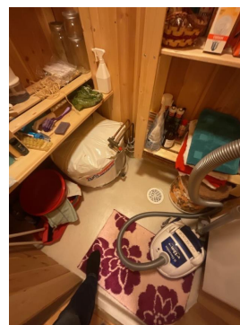
Varmtvannstank har avrennings mulighet til sluk.
