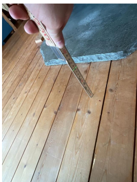
Cirka 15mm høydeforskjell innenfor for 2 meter.
