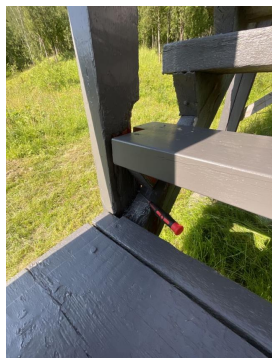
Første trinn på trapp er råteskadet.
