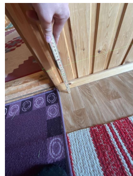
Høydeforskjell i gang er cirka 20mm.
