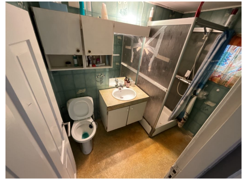
Fastskrudd deksel dusjkabinett - ikke sjekket sluk
