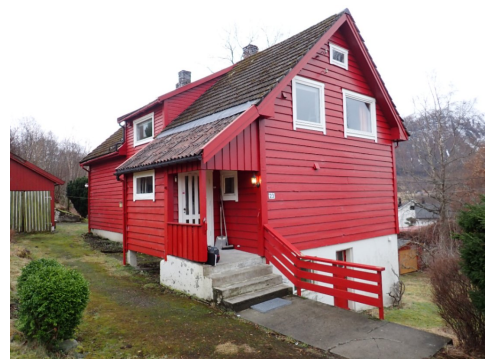
Mangler rekkverk på siden
