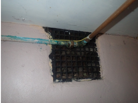
Korrosjonskader kobberør
