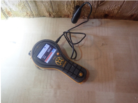
Trepanel med 100 % utslag på fukt
