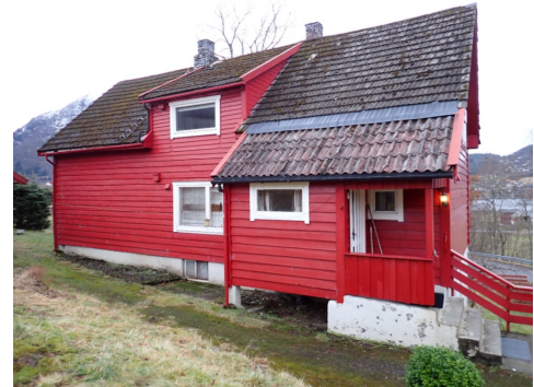
Bølgeeternitt over tilbygget inngangsparti
