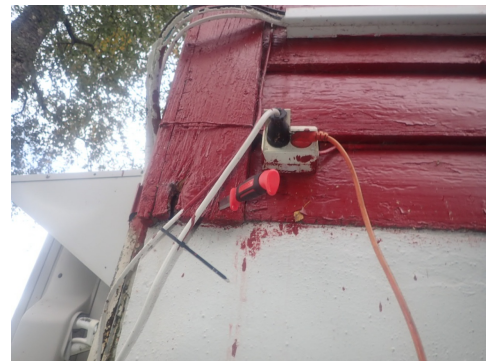
Råteskader sørvest
