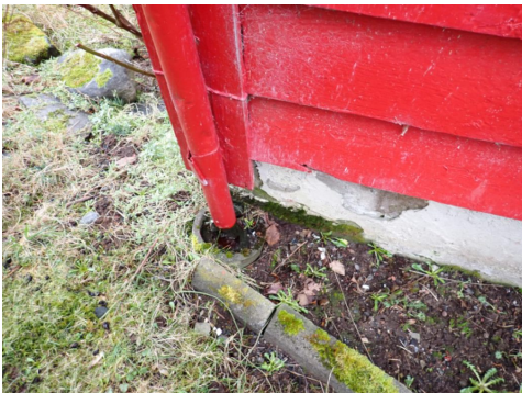
Begge taknedløp avsluttet over bakkenivå på østsiden
