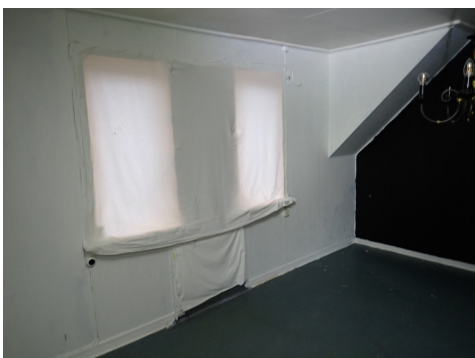
Tildekt/avsperrert balkongdør og vindu
