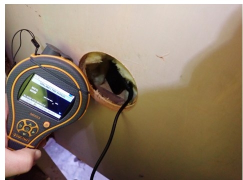
Ingen fukt målt i vegg
