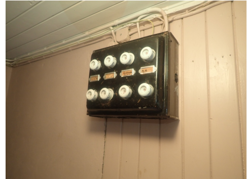
Sikringer kjeller fra byggeår
