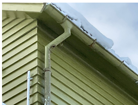
Utsnitt av takrenne og -nedløp.
