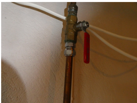
Siklemikk til drenering av fordelerskap.
