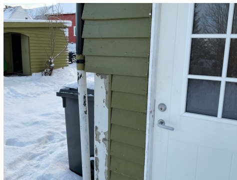
Taknedløp tilknyttet rør til grunnen.
