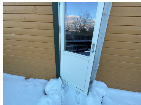
Verandadør - til takterrasse.
