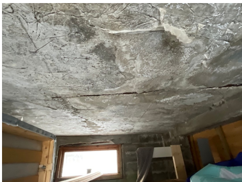
Et parti med eksponert av armering.
