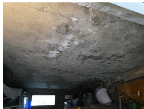
Et parti med eksponert av armering.
