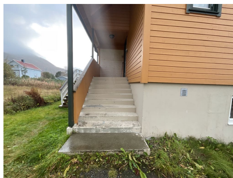
Trapp sett nedenfra.
