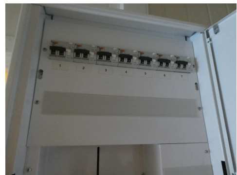
Elektrofordeler på loftplan.
