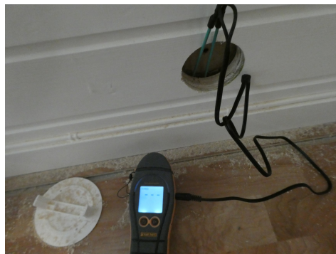
Hulltaking utført i utforing - ingen fukt registrert.
