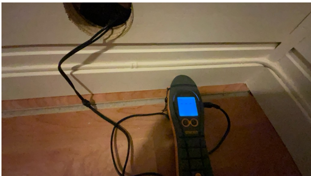
Hulltaking i utført utforing - ingen fukt registrert.
