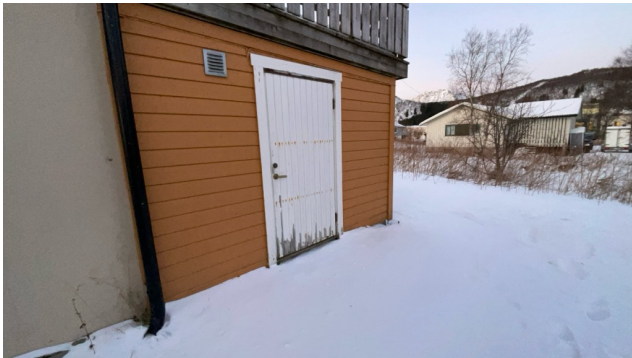
Dør til bod under takterrasse.
