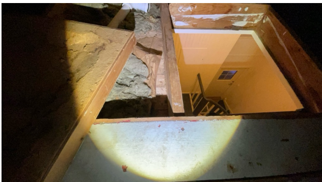
Løs luke i himling for tilkomst til loftsrom.
