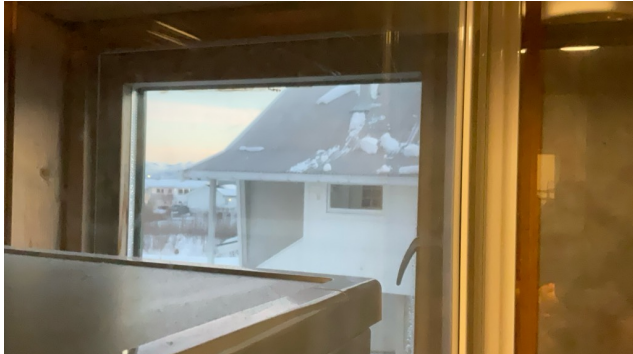
Luftvindu uten spalteventil.
