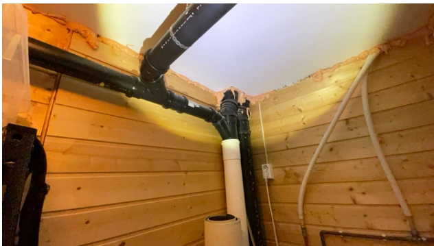
Utsnitt av avløpsrør i bod i kjeller.
