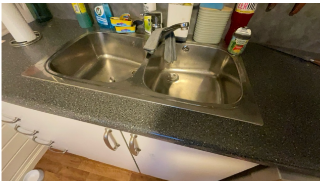
Kumbeslag innfelt i benkeplate.
