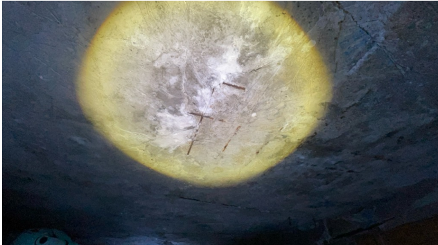
Utsnitt av dekke med eksponert armering.
