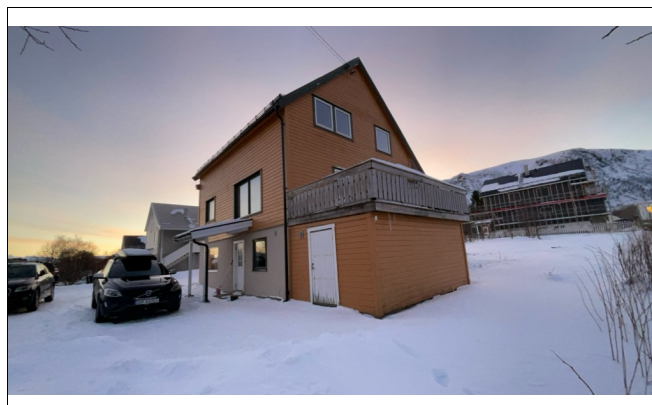
Fasader mot nordøst og nordvest.
