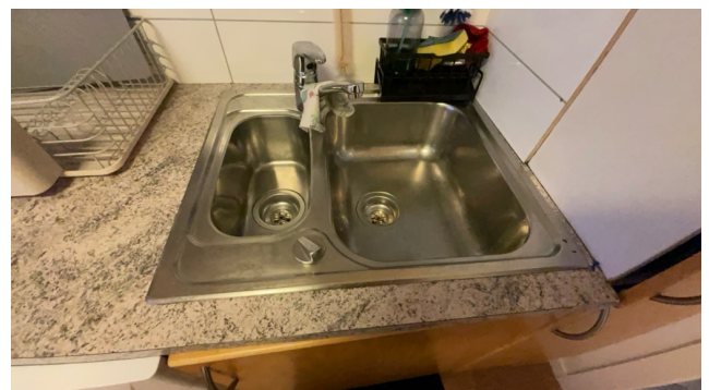
Kumbeslag innfelt i benkeplate.
