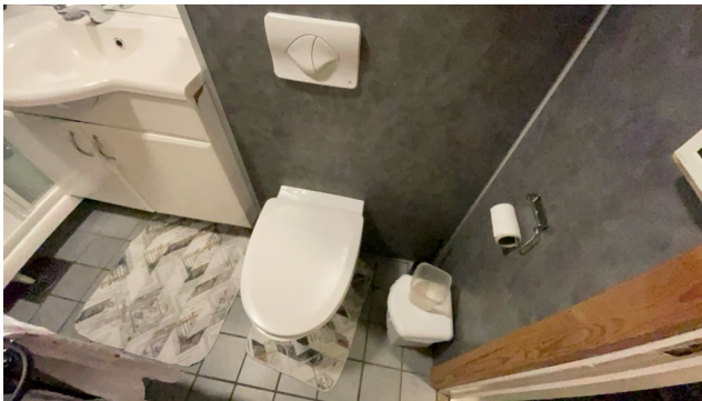
Utsnitt av bad/vaskerom.
