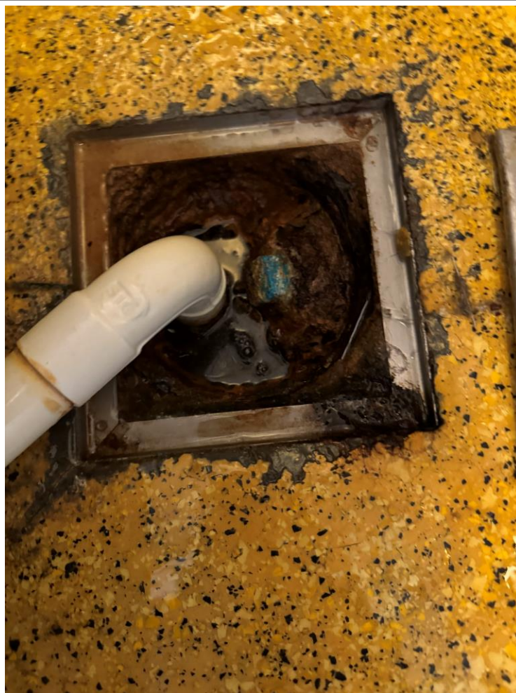
Bilde av sluk på badet i 2.etasje.
