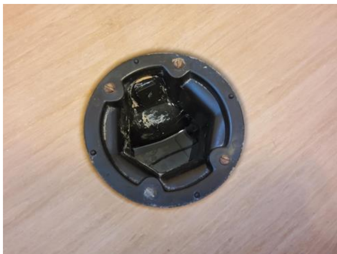
Helhetsvurdering - [Sluk bad 1.etasje]
