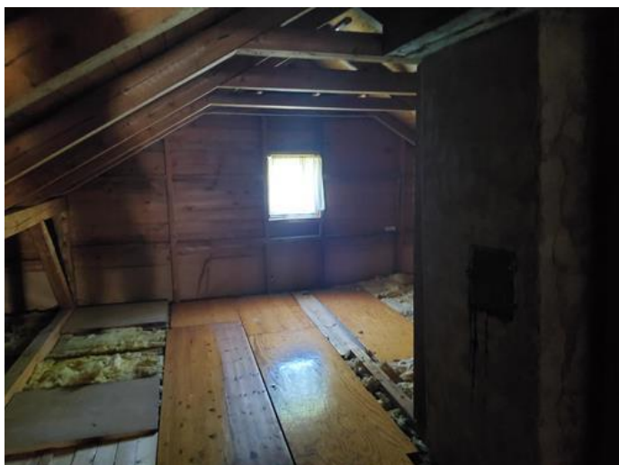
Loft - uinnredet / råloft - [Kaldtloft]
