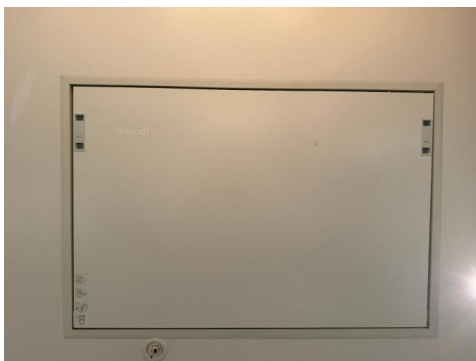
Luftbehandlingsaggregat i himling på vaskerom.
