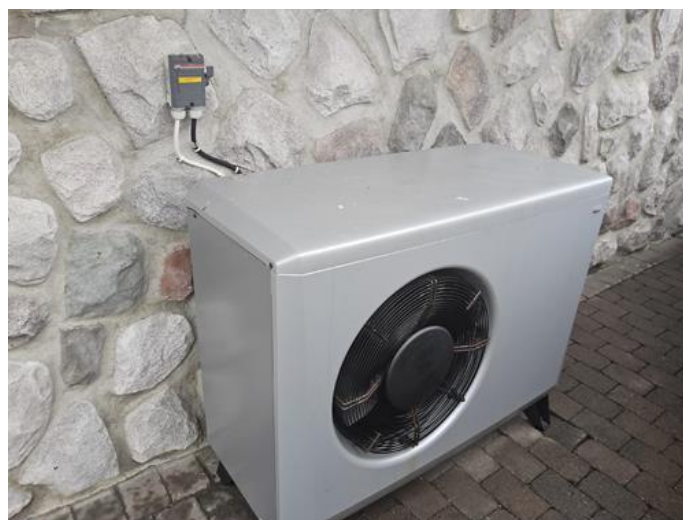
Tekniske anlegg, VVS anlegg (Sjekkpunkter utover det som er inkludert i andre rom) - [Utvendig del til varmepumpe.]
