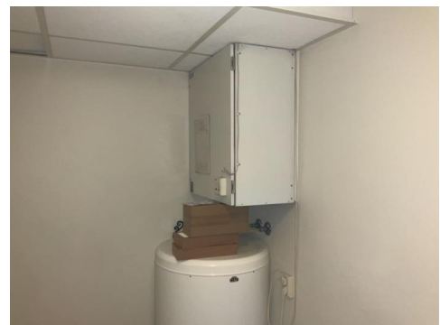
balansert ventilasjons
