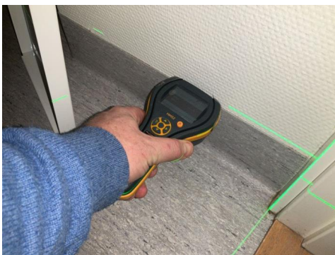
fuktsøk, ikke funnet avvik
