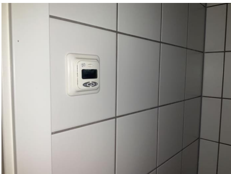
termostat gulvvarme
