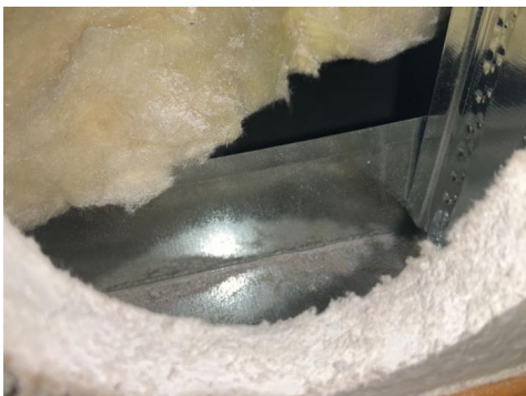
hull for inspeksjon
