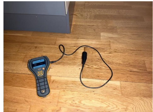
fuktsøk i sprekker i parkett, ikke funnet indikasjoner på fukt kjøkken
