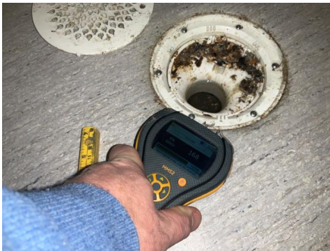
fuktsøk, ikke funnet avvik
