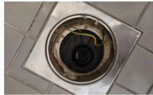
Avløpsrør (ink. sluk) - [Sluk i dusj]
