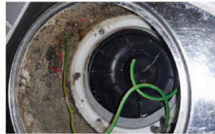
Avløpsrør (ink. sluk) - [Sluk under servant]
