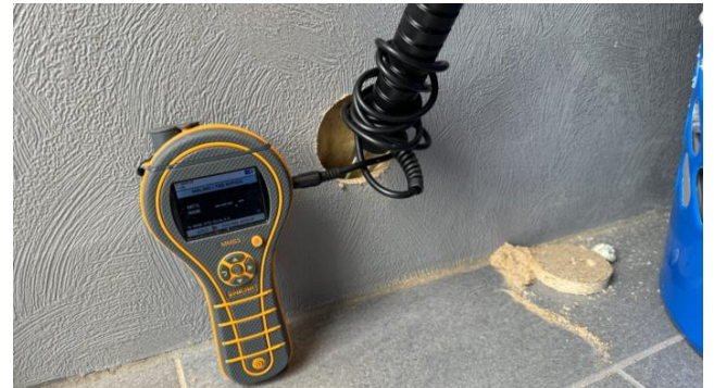
Bilde viser målinger ved hulltaking fra tilstøtende rom.
