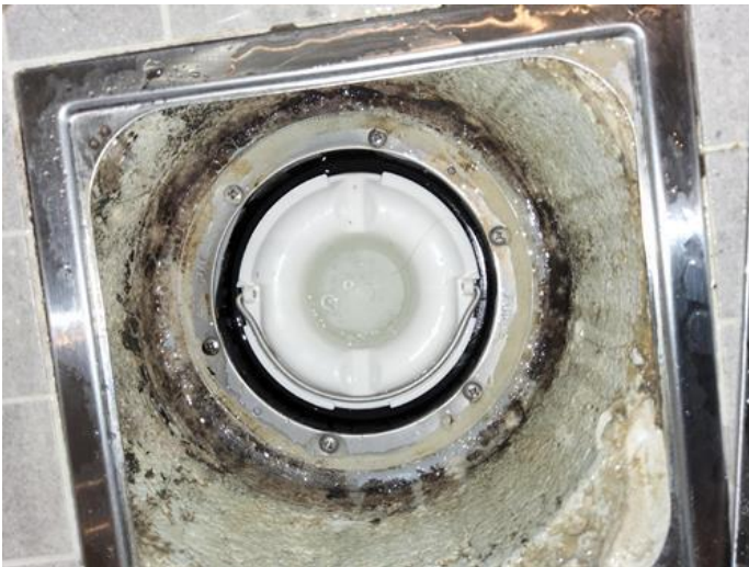
Membran, tettesjikt og overgang til sluk. - [Sluk]
