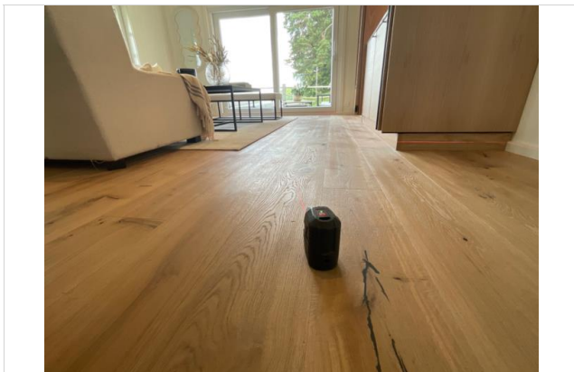
Nivellering stue/kjøkken ingen avvik registrert
