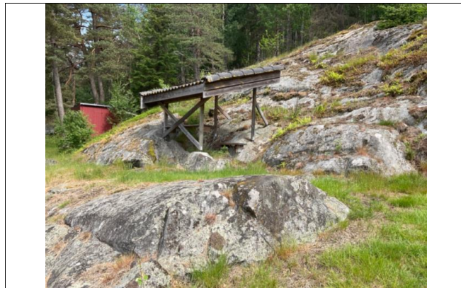
Overbygget enkel uteplass på ca. 5,5 kvm. Oppført i bindingsverk søyler forankret til fjell i bjelkesko, pulttak tekket med takstein, benker i terrassebord.
