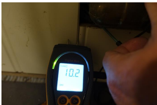
Innforet vegg i bakkant.
