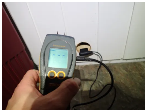
Fuktmåling i utforet vegg uten negative utslag.
