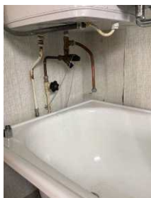
Røropplegg under varmtvannsbereder
