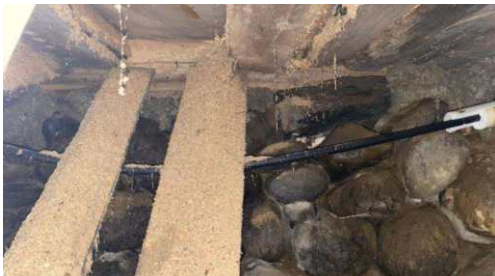
Skade gulvkonstruksjon
