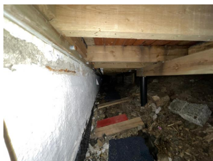
Terrenghorhold mot grunnmur
