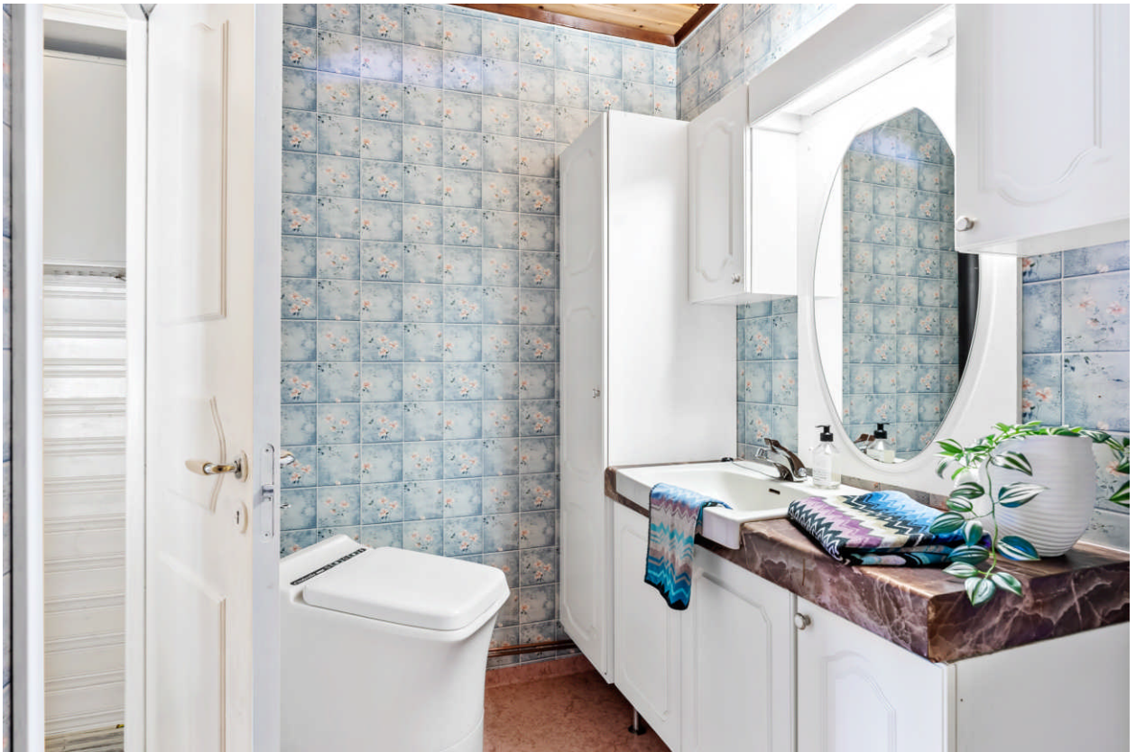
Toalettrom med romslig servantinredning og Cinderella forbrenningstolett.
