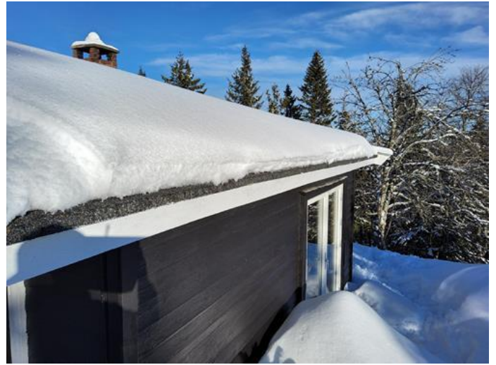
Utvendig - [Takutstikk mot sør]
