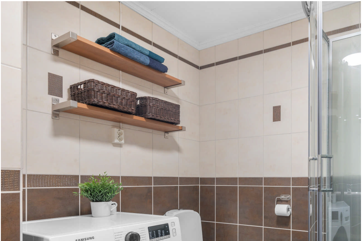
Det er dusjkabinett på badet som sikrer trygg avrenning. Opplegg for vaskemaskin.
