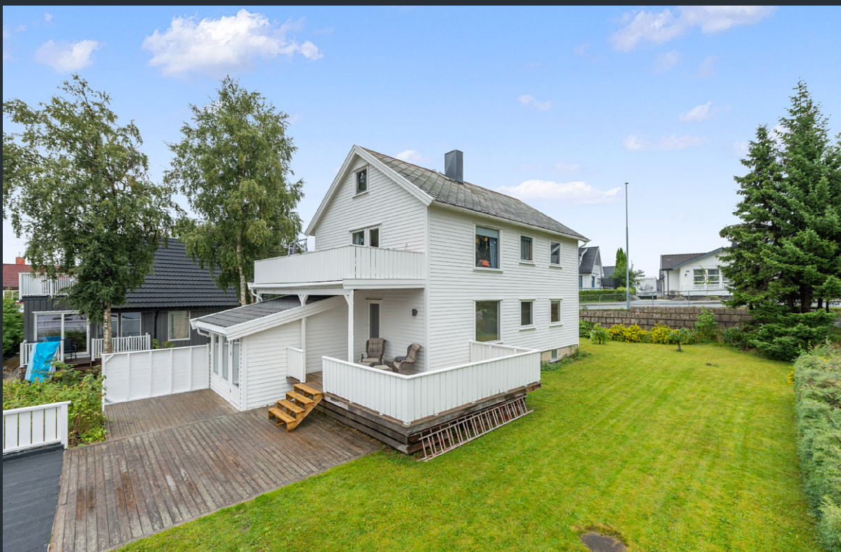
I ca 2003 ble vinduer, kledning (også etterisolert) og dører skiftet. I tillegg ble det meste av dreneringen utbedret.
