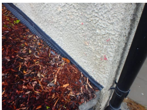
Synlig fuktsikring utvendig på mur.
