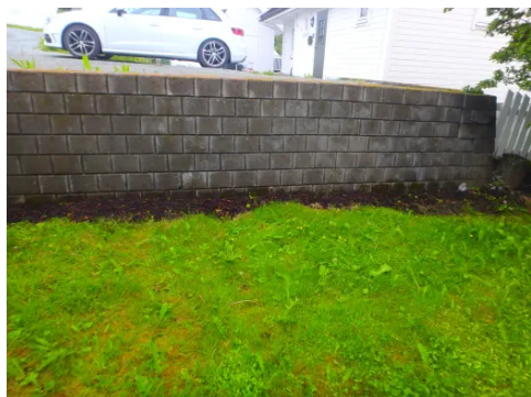
Støttemur av betongstein mot nabo.
