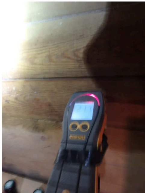
Fuktmåling i tregulv i vinkjeller.
