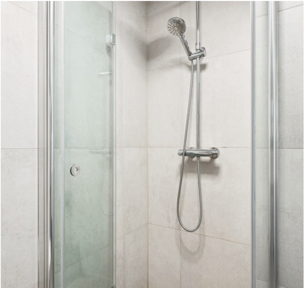
Dusj på bad i 2.etg.
