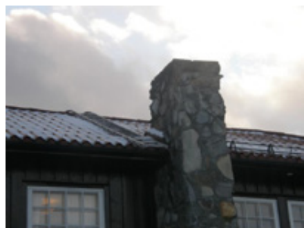
Pipe og tak
