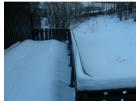
Veranda ut fra kjøkken
