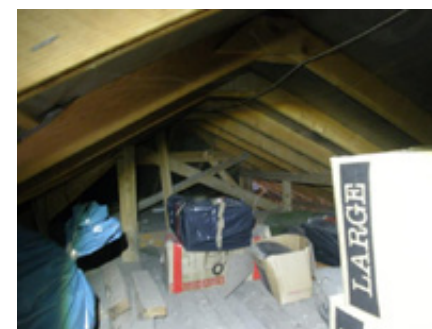
Sperretakkonstruksjon
