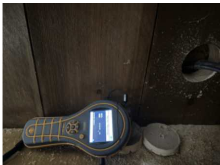
Måling etter fukt i vegg mot bad.
