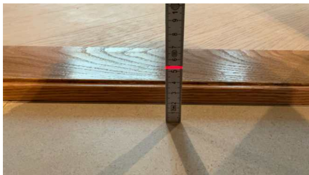
Høyde gulv ved dør.
