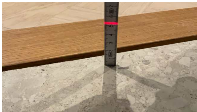
Høyde gulv ved dør.
