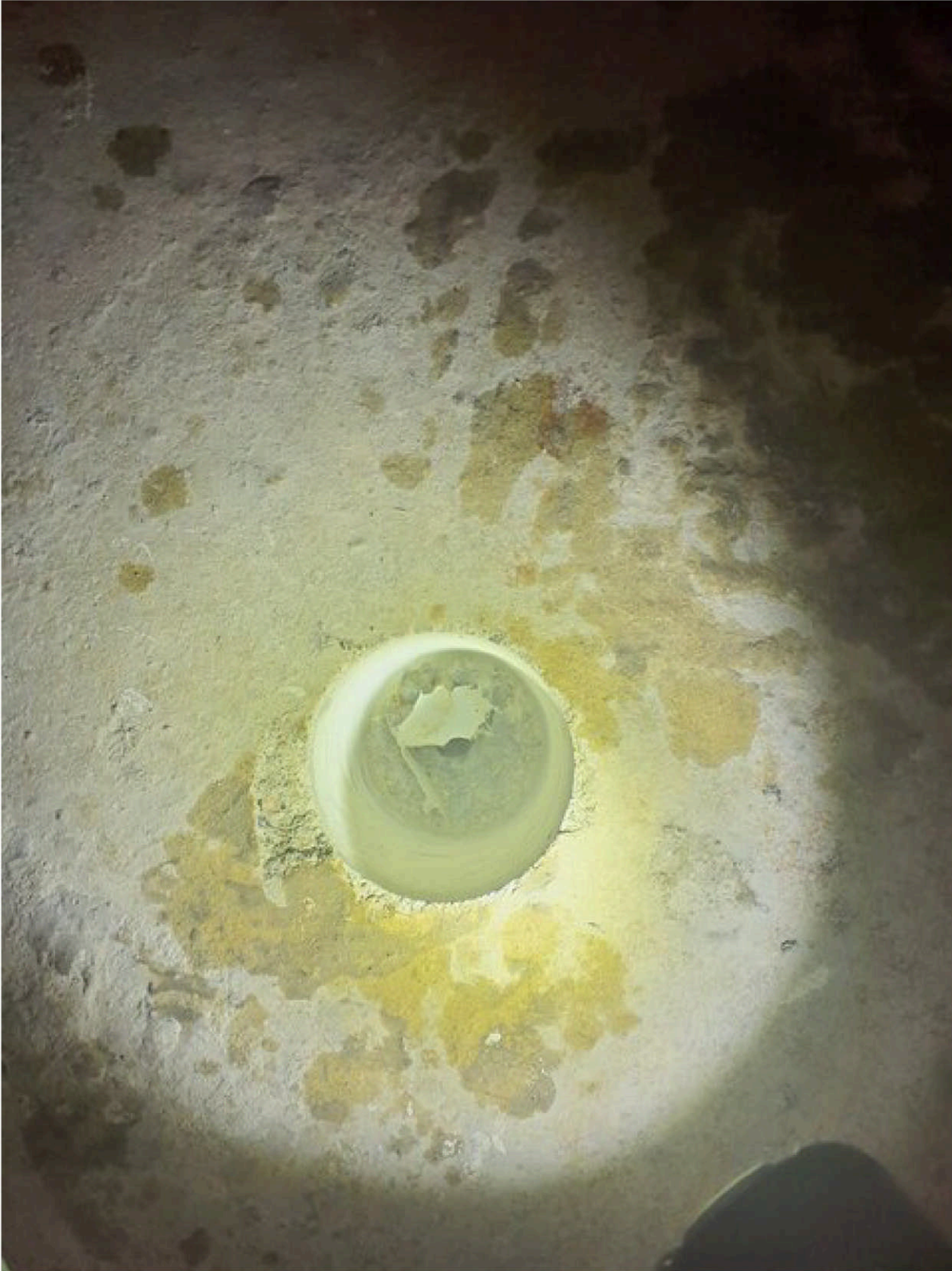
Innspeksjonshull 50mm betongkonstruksjon med plast under.
