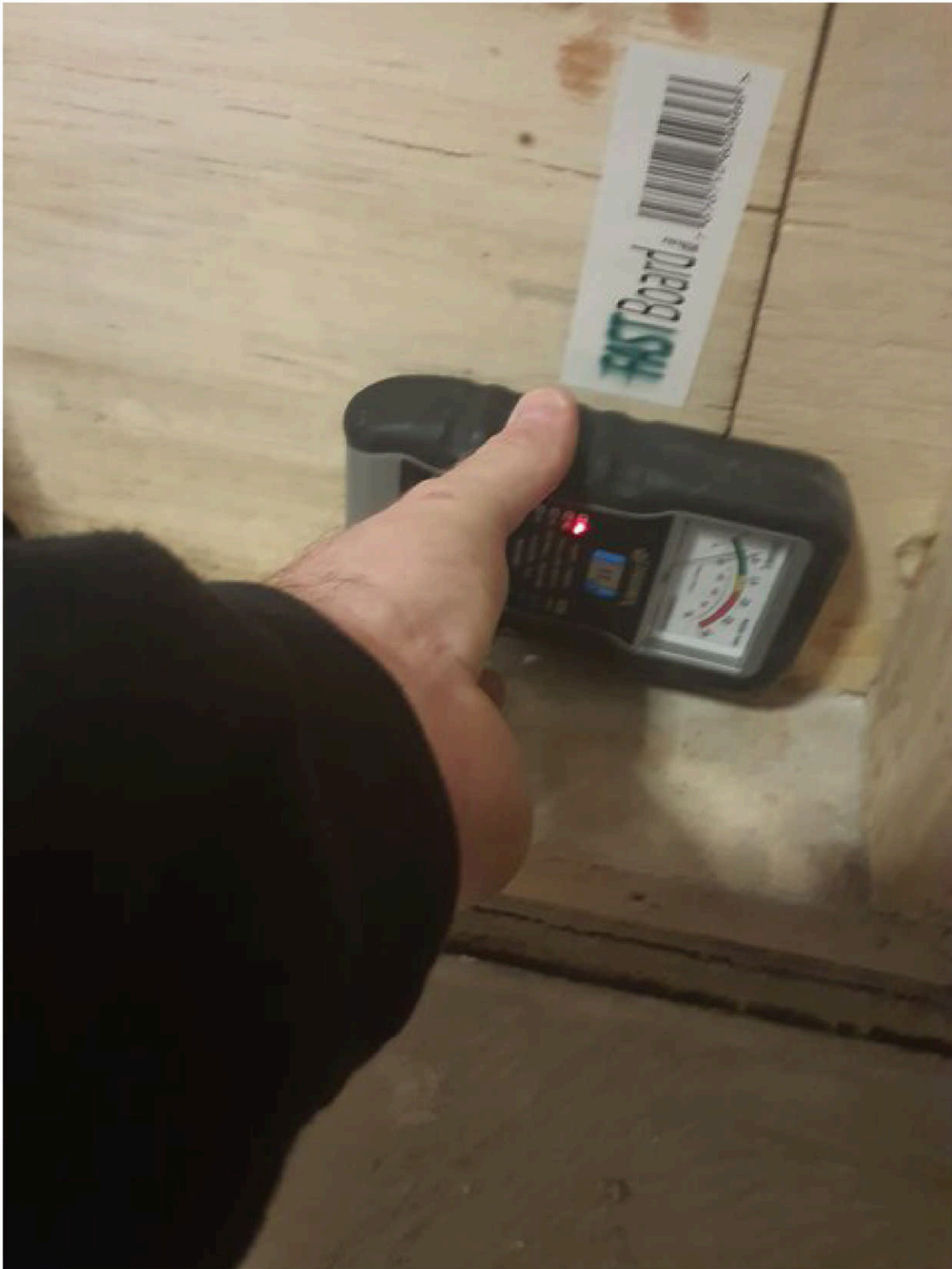
Tramex måling av vegg mot bad
