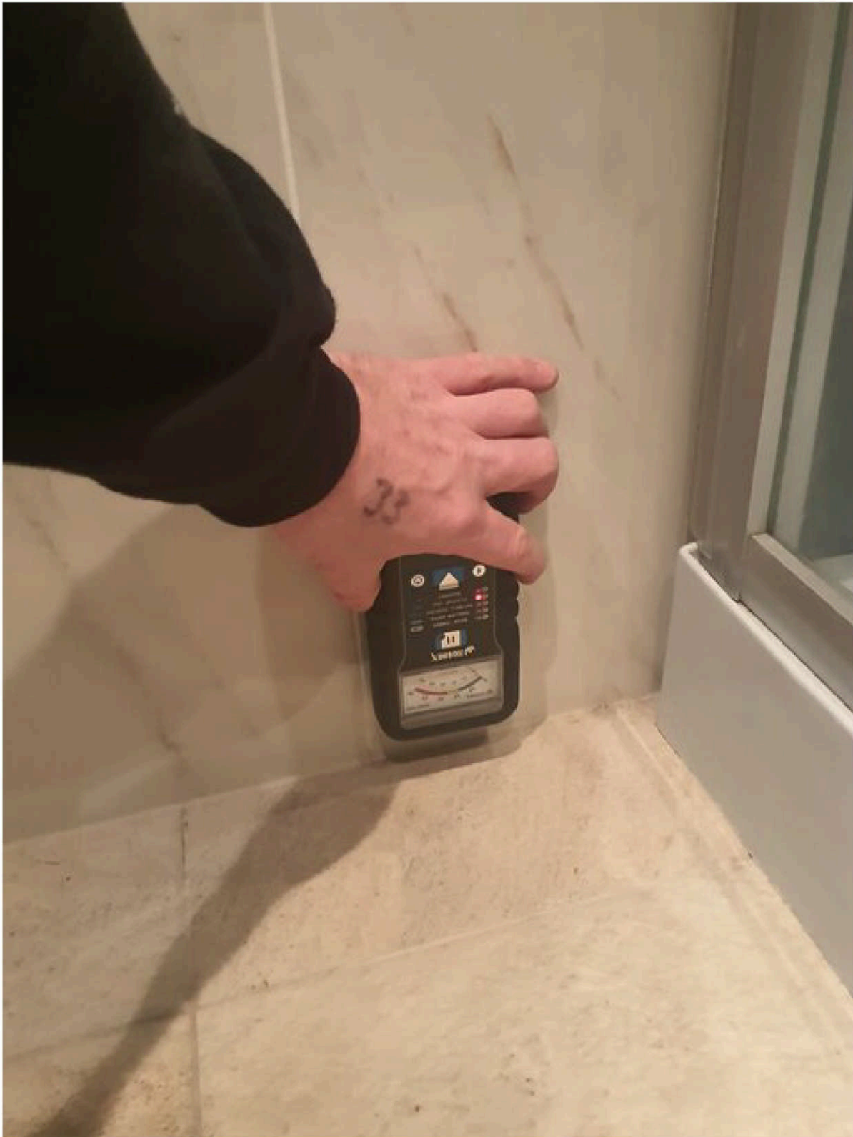
Bad tramex måling av vegg
