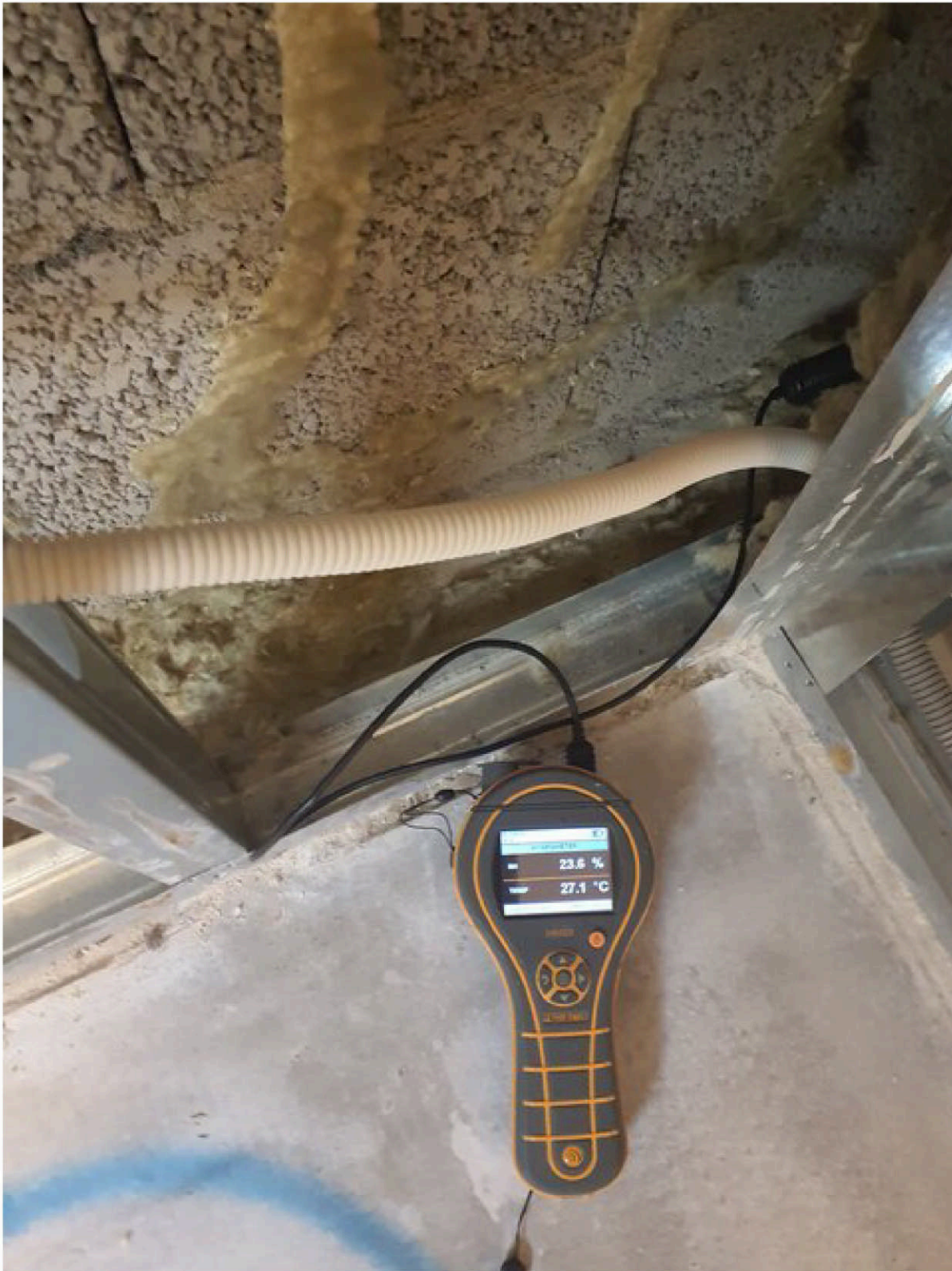
Mp9 hovedel soverom. måling av isolasjon I vegg
