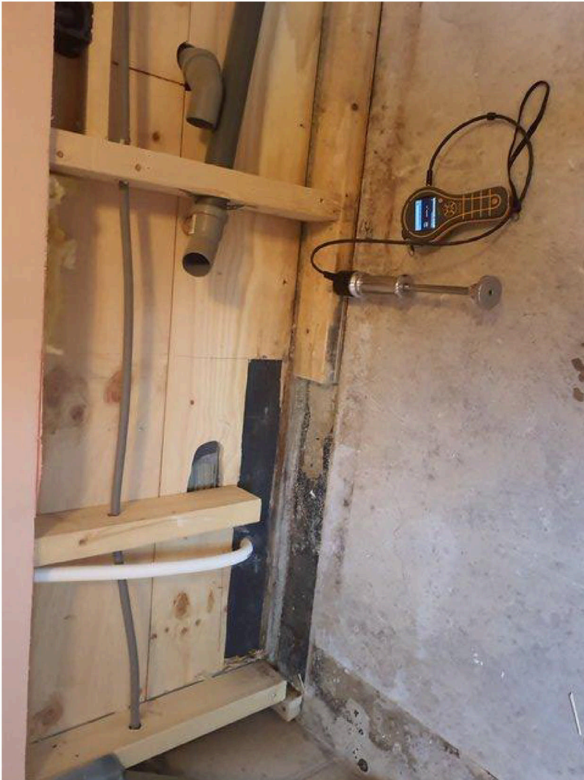
Mp 10 Soverom måling av bunnsvill mot bad
