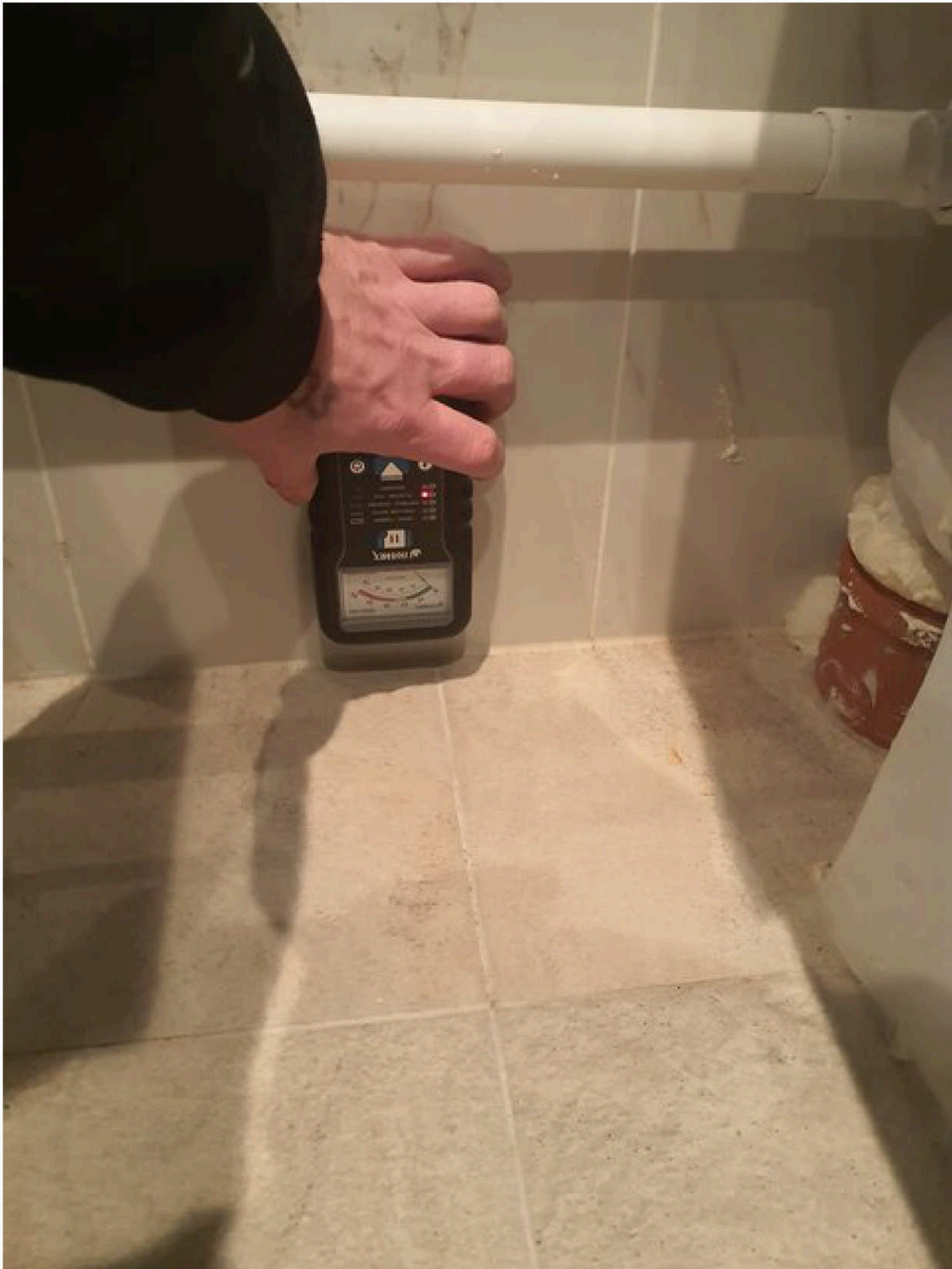
Bad tramex måling av vegg
