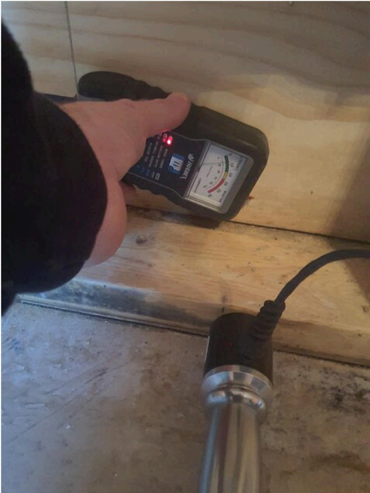
Tramex måling av vegg mot bad
