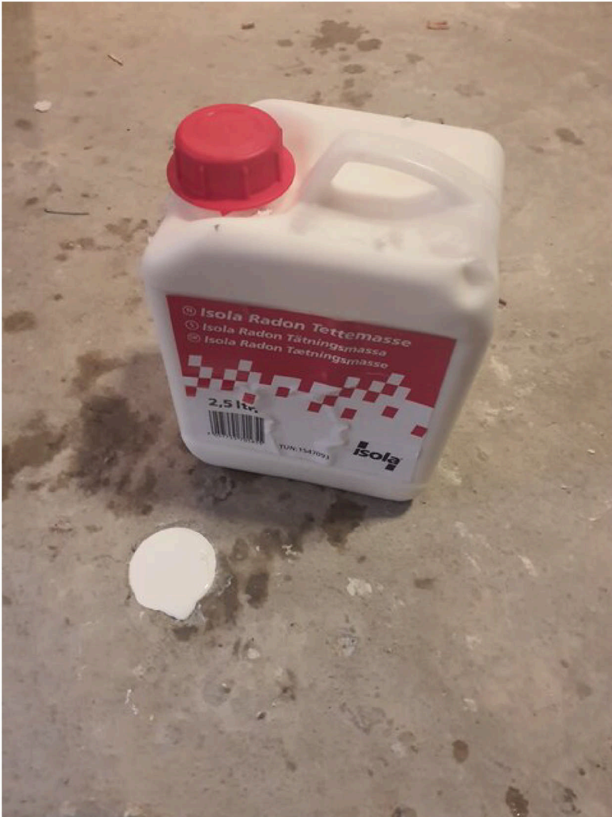
Innspeksjonshull 50mm tettet med radon tettemasse.
