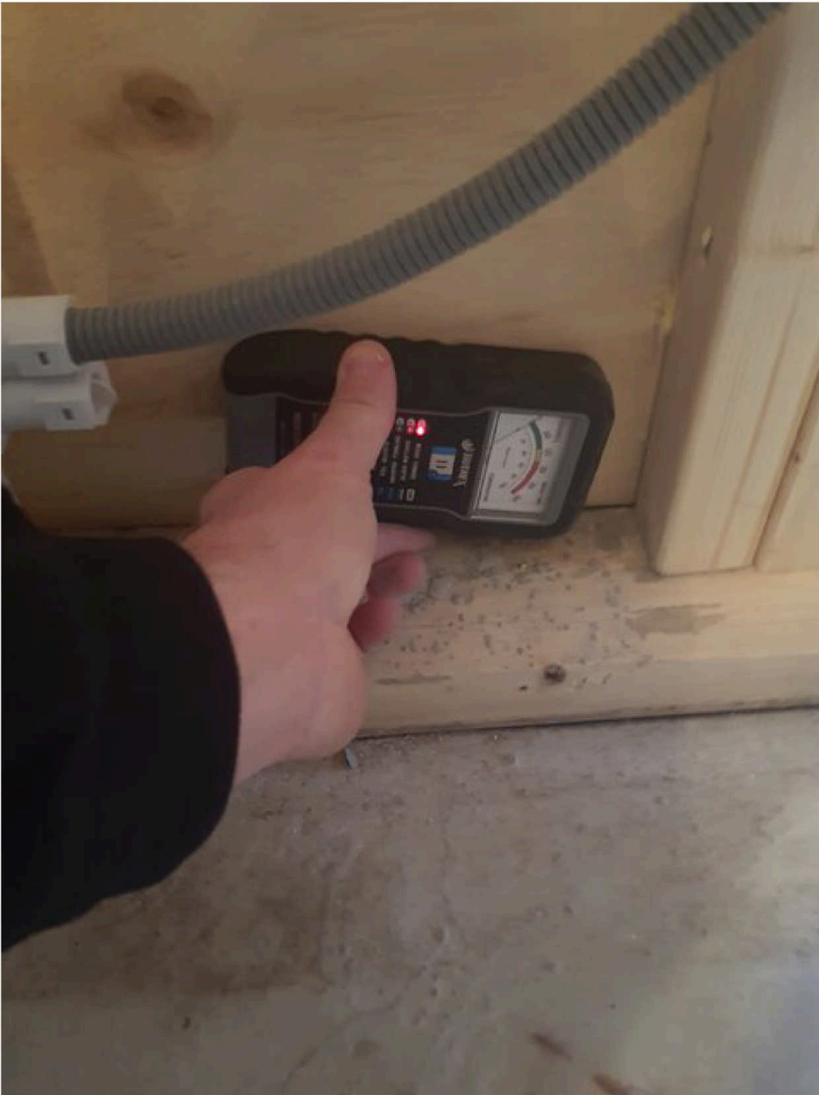
Tramex måling av vegg mot bad
