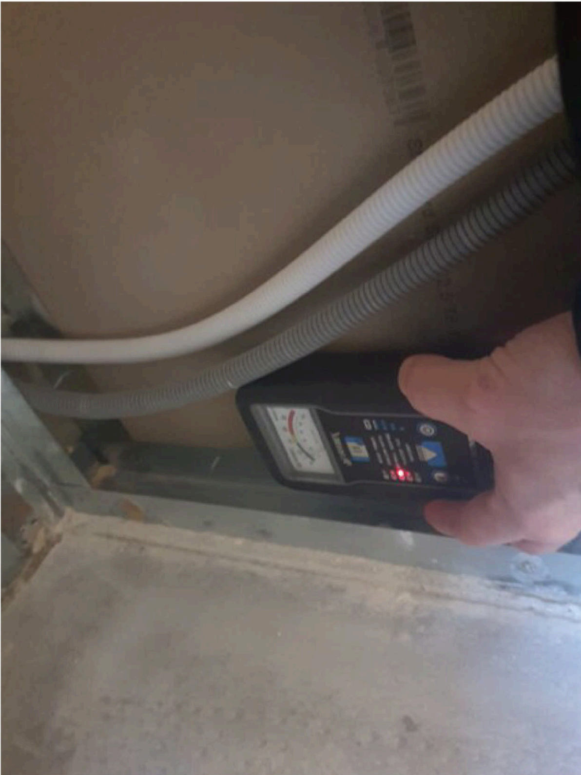
Hovedel soverom tramex måling av gipsvegg
