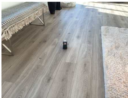
Ingen spesielle skjevheter i etasjeskillene.
