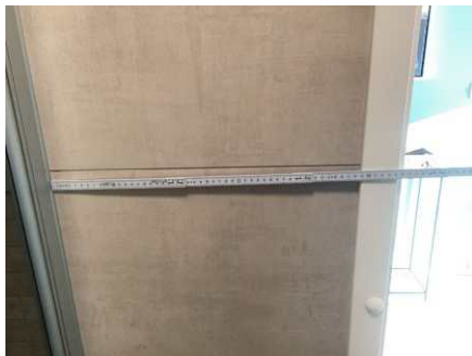
For kort avstand mellom dusjen og døren.
