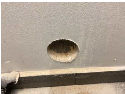
Trefiberplater, gips rett på grunnmuren, thermomur.
