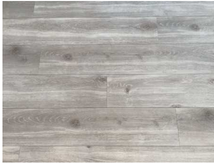
Laminatgulvet i samtlige oppholdsrom i 1 og 2 etg.
