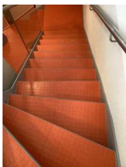
Trappen ned til kjeller. Gummibelegg i trinnene.
