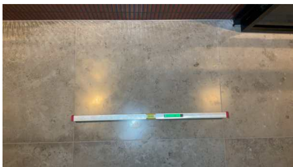
Fra dusjens nedslagsfelt (15mm/m)
