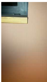
Mindre riss på vegg på soverom i kjeller.
