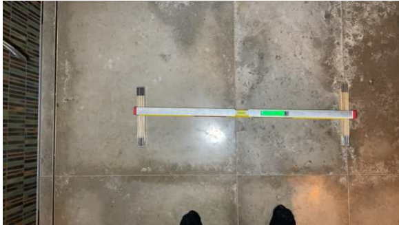
13mm/m fra dusjens nedslagsfelt.
