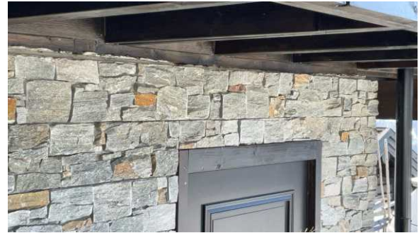
Bildet viser overgang mellom trekonstruksjon og forblending på yttervegg i underetasjen.
