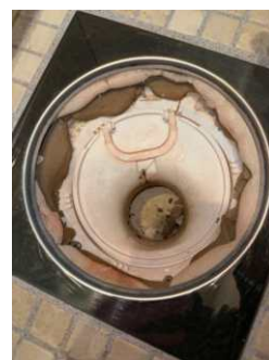
Manglende membran/tettesjikt i våtsoner.
