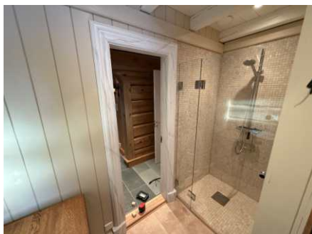
Manglende membran/tettesjikt i våtsoner.
