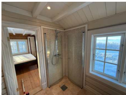
Dør og vindu i våtsone til dusj.
