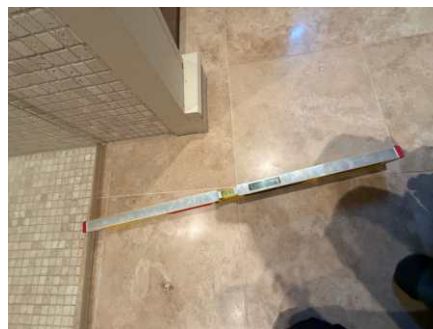
Tilnærmet flatt gulv utenfor dusjsone.
