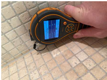
Fuktsøk på overflater.
