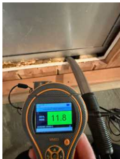
Måling etter fukt i vegg mot bad.
