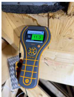
Måling etter fukt rundt luftehatt (tørt).
