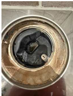
Sluk med synlig eldre belegg (dusj).
