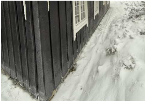
Terreng mot mur.
