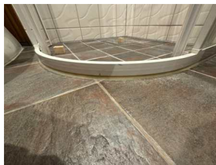
Tett sokkel mot dusjsone og sluk.
