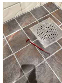
Tett sokkel mot dusjsone og sluk.
