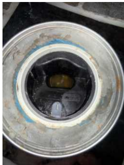
Sluk med synlig eldre belegg (dusj).
