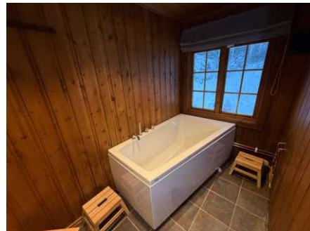
Manglende membran i våtson
