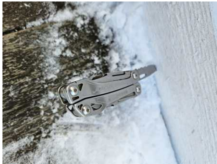
Påbegynnende råteskade på liggende kledningsbord i 2. etasje.
