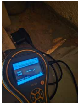
Måling av trefukt i konstruksjon bak toalett.
