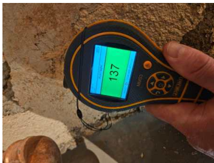
Fuktsøk på vegg bak dusjsone.
