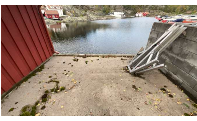
Utsnitt bryggeanlegg, betongbrygge med fortøyningslenge på ca. 4m 2 .
