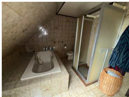
Bad/wc fra byggeår
