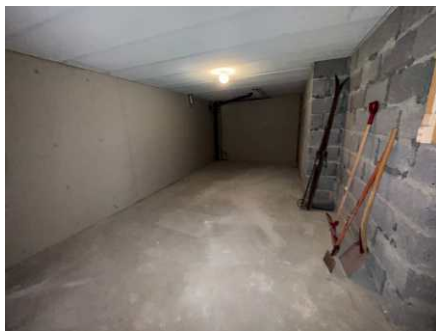
Grunnmuren er et ferdig isolert bygningselement. (sandwich-element)
