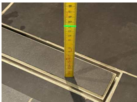
Fallforhold ca. 141 mm topp slukrenne ved vegg i dusjsone
