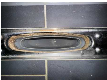
Slukrenne ved vegg i dusjsone og synlig membran/mansjett
