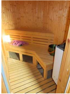
Badstue med tremmegulv og plassbygde benker. Elektrisk badstueovn.
