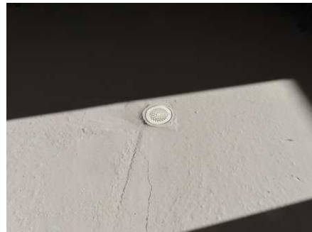
Sluk i garasjergulvet for avrenning.
