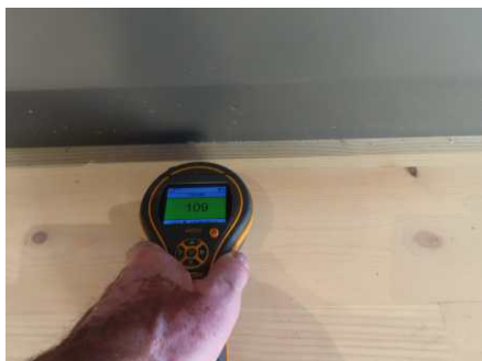
Fuktsøk på gulv foran benkeskap og oppvaskmaskin - ingen påviste forhøyede fuktverdier.
