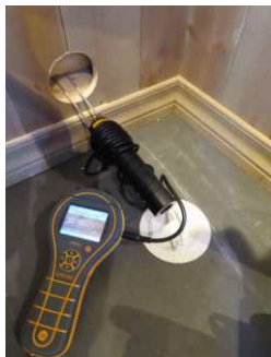
Fuktsøk mot våtrom - Naturlige utslag - ingen forhøyede fuktverdier.
