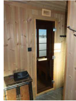
Badstuedør som hel glassdør utadslående til bad ved hovedsoverom samt dør inn på bad/kombinert vaskerom.
