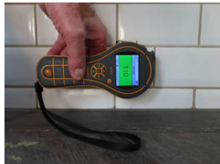
Overflatesøk i dusjsone - normale verdier, ingen påviste avvik.
