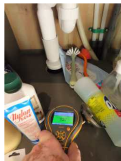
Fuktsøk i benkeskap - ingen påviste forhøyede fuktverdier. Det er registrert være montert lekkasjevarsler med føler i skapbunn/gulv under skapet.
