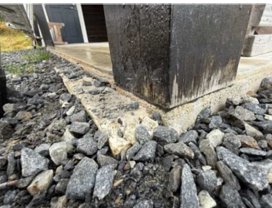
Søyler til carport.
