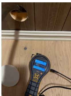
Måling etter fukt i vegg mot bad.
