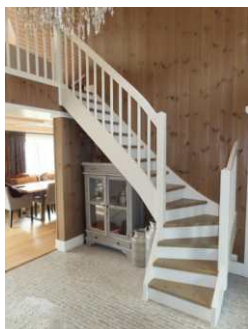
Det mangler håndløper på vegg - begge trapper.
