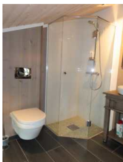
Dusjnise med fliser. Vegghengt toalett med innebygd systerne.
