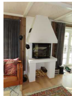
Peis med støpejernsinnsats i kjøkken/oppholdsrom. Murt og pusset omramming.
