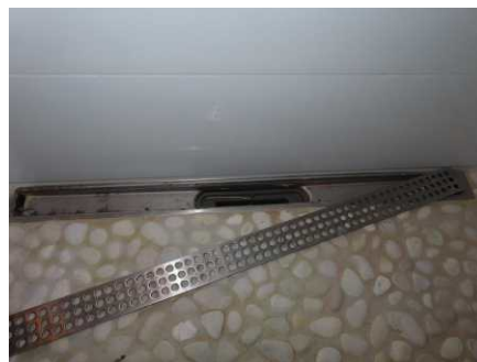
Slukrenne i dusj - Purussluk med flersjikt oppbygging.
