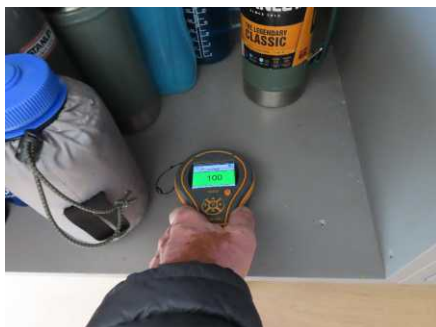
Fuktsøk i benkeskap - ingen påviste forhøyede fuktverdier.
