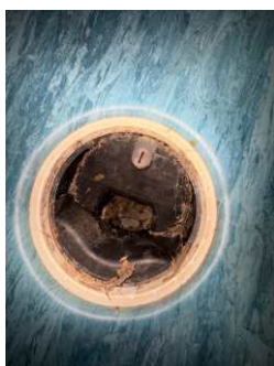
Manglende tettesjikt på vegger i våtsoner.
