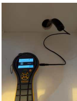
Måling etter fukt i vegg mot bad.
