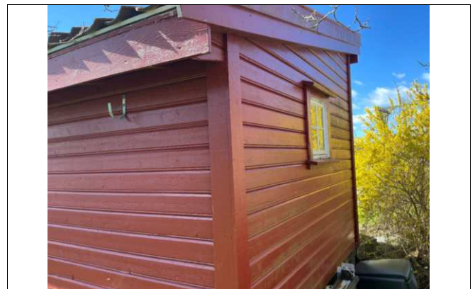
Tekket med «gamle» teglstein og underliggende papp. Det er ikke montert takrenner eller pannebeslag
