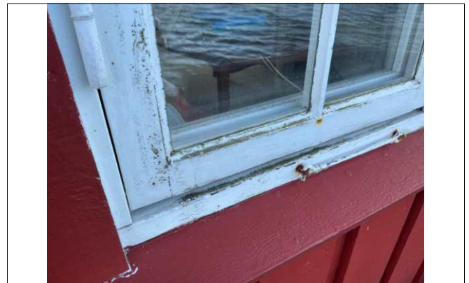
Vindu med koblet glass. Normalt vedlikehold må påregnes
