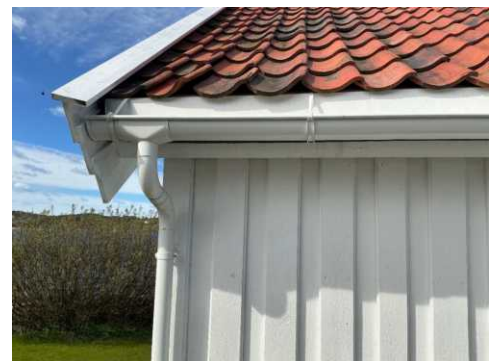
Ny takrenner på hovedhytte
