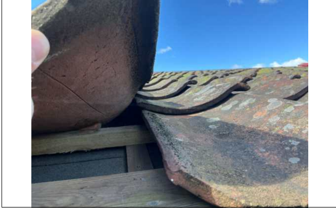
Stikkontroll av undertak. Normal slattsje registrert
