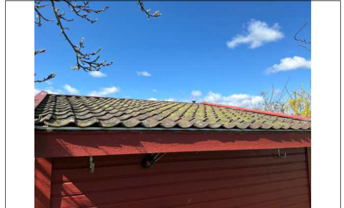
Tekket med «gamle» teglstein og underliggende papp. Det er ikke montert takrenner eller pannebeslag
