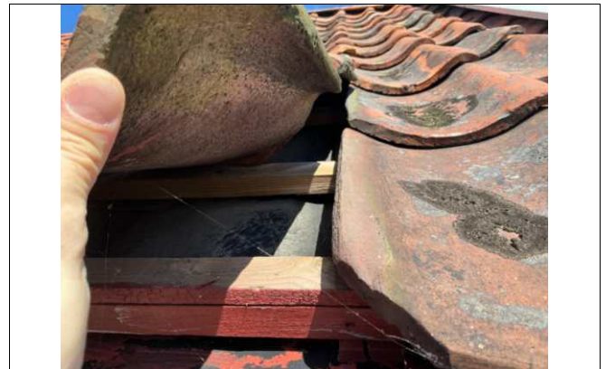
Stikkontroll av undertak. Normal slattsje registrert
