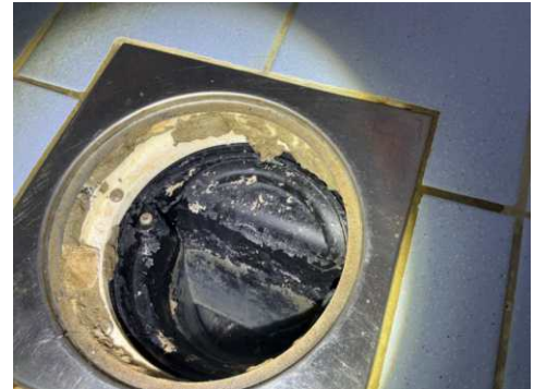
Ingen membran registrert i sluk
