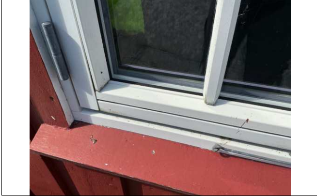
Nyere vindu med isolerglass
