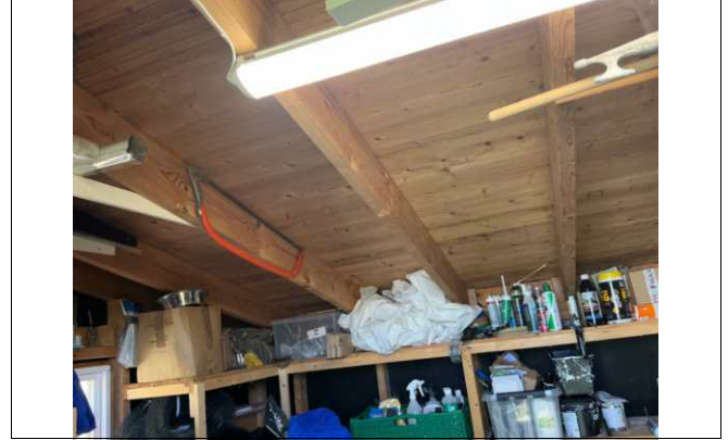
Ingen synlige lekkasjer registret i undertak ved befaringen
