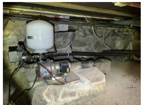
Deler av synlig opplegg i krypkjeller
