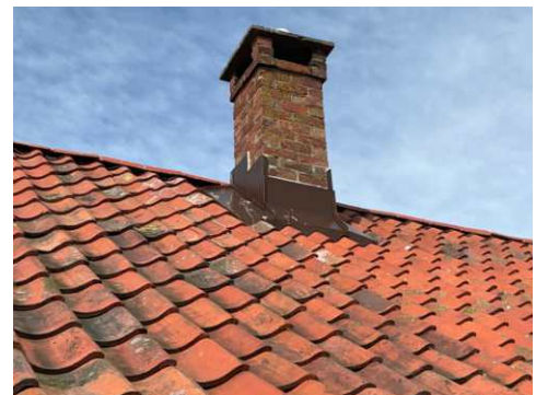
Pipe med beslag i overgang
