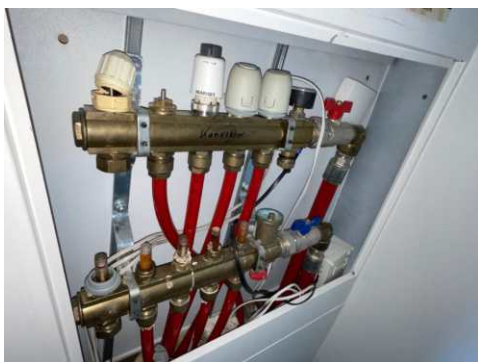
Fordelerskap gulvvarme.
