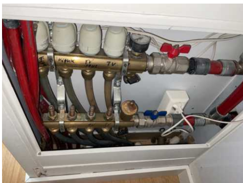
Fordelerskap gulvvarme.
