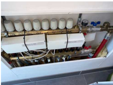
Fordelerskap gulvvarme.
