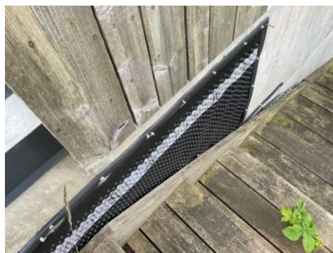
Stedvis synlig grunnmursplast.
