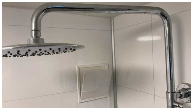
Veggventil med naturlig ventilering.
