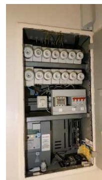
El-skap med skrusikringer i leilighet vest. Mangler kursfortegnelse.
