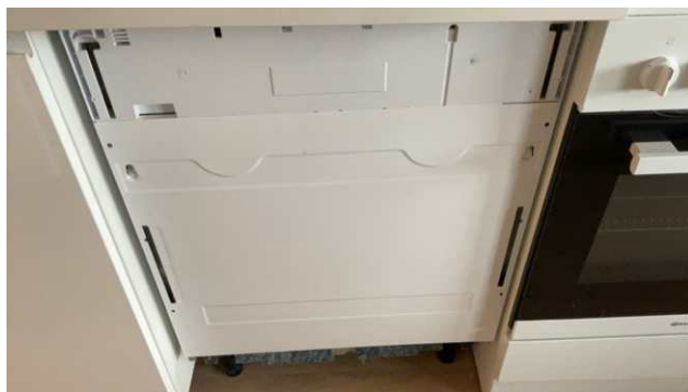
Frontdeksel må monteres på oppvaskmaskin.
