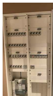
El-skap med skrusikringer i leilighet vest. Mangler kursfortegnelse.
