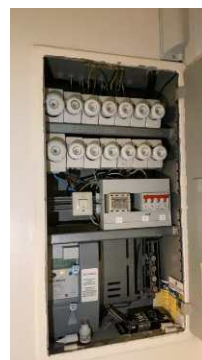
El-skap med skrusikringer i leilighet vest. Mangler kursfortegnelse.
