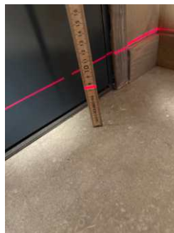
Nullpunkt på laser er 6cm. Avvik er 15mm på tvers fra garderobe til kjellerstue.
