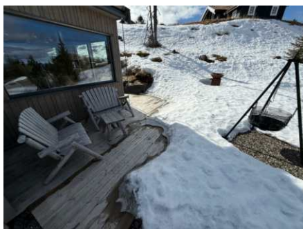
Deler av terrassen var tildekket med snø.
