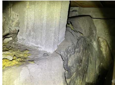
Luke inn til krypkjeller.
