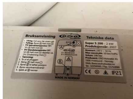
Spekk på varmtvannstank.
