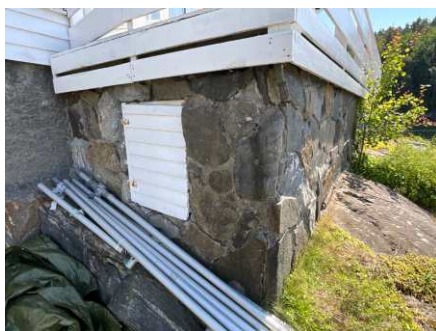
Del av forstøtningsmur.
