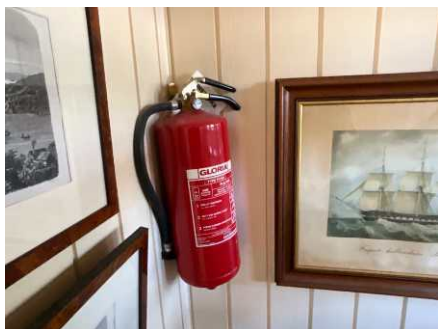
Håndholdt brannslukningsapparat.
