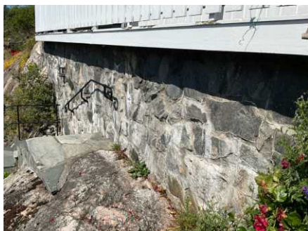
Del av forstøtningsmur.
