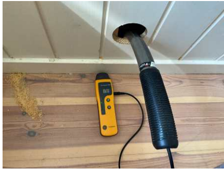
Hull for kontroll av fukt.
