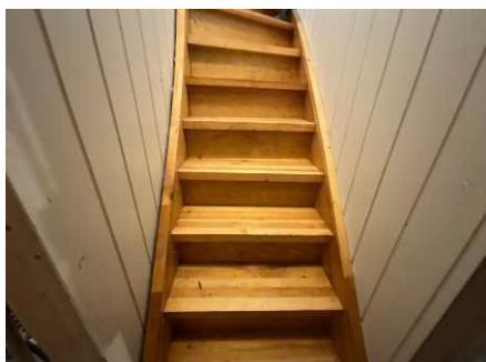
Trapp opp til 1 etasje.
