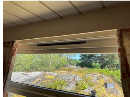
Eksempel på montert ventil i vindu.
