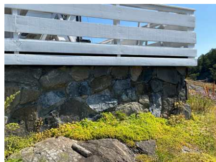
Del av forstøtningsmur.
