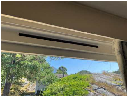
Eksempel på montert ventil i vindu.
