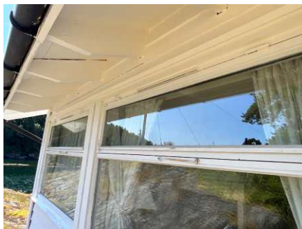
Eksempel på montert ventil i vindu.
