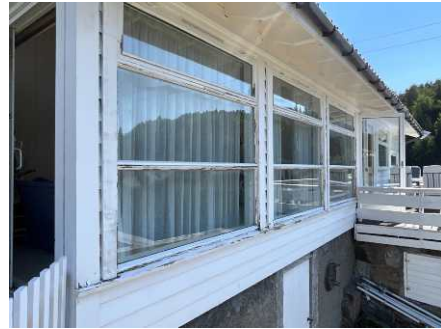
Eksempel på vindu i yttervegg.
