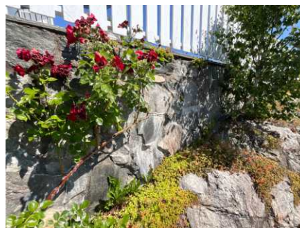
Del av forstøtningsmur.
