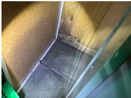
Del av rom under terreng.
