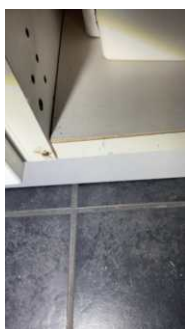
Svak svelling i bunnplate på et skap.
