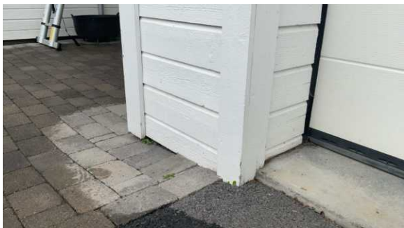
Kledning mot terreng.
