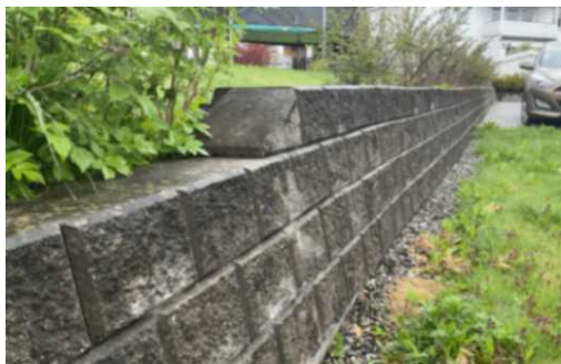
Forstøtningsmur mot øst.
