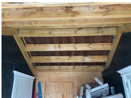
Tak mellom bolig og bod.
