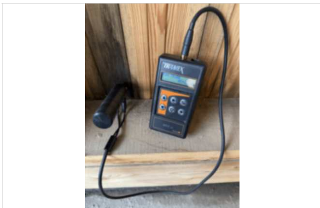
Fuktmåling panel garage. 23 vektprosent.
